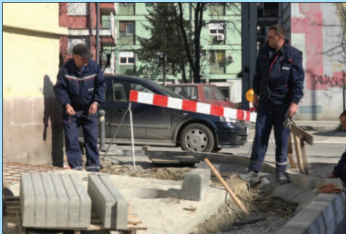
Радови касне због замене водоводне и топлотне мреже
