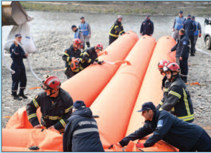
Постављање противпоплавних система на градској плажи
