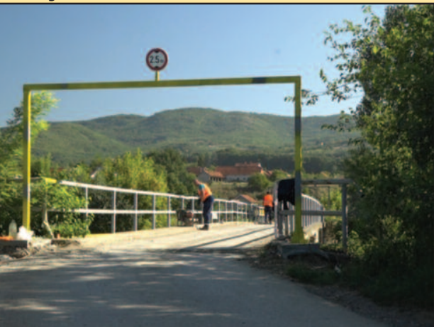
Портал ограничава висину возила на два и по метра
