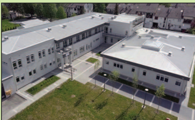
Зграда за нови век-завршена изградња зграде ЗЗЈЗ Краљево
