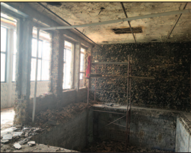
Базен ће се проширити и уградити нове цеви због агресивног сумпора
