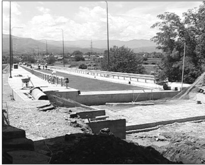
Сви радови на мосту треба да буду завршени до понедељка
