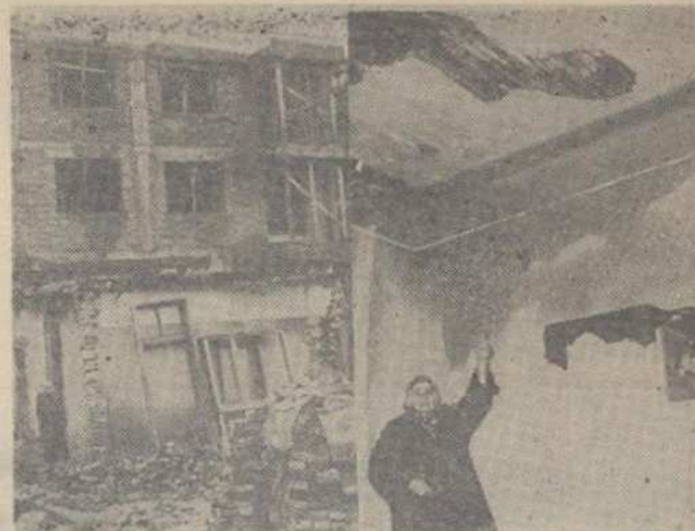
Милка Радовић у порушеном стану
