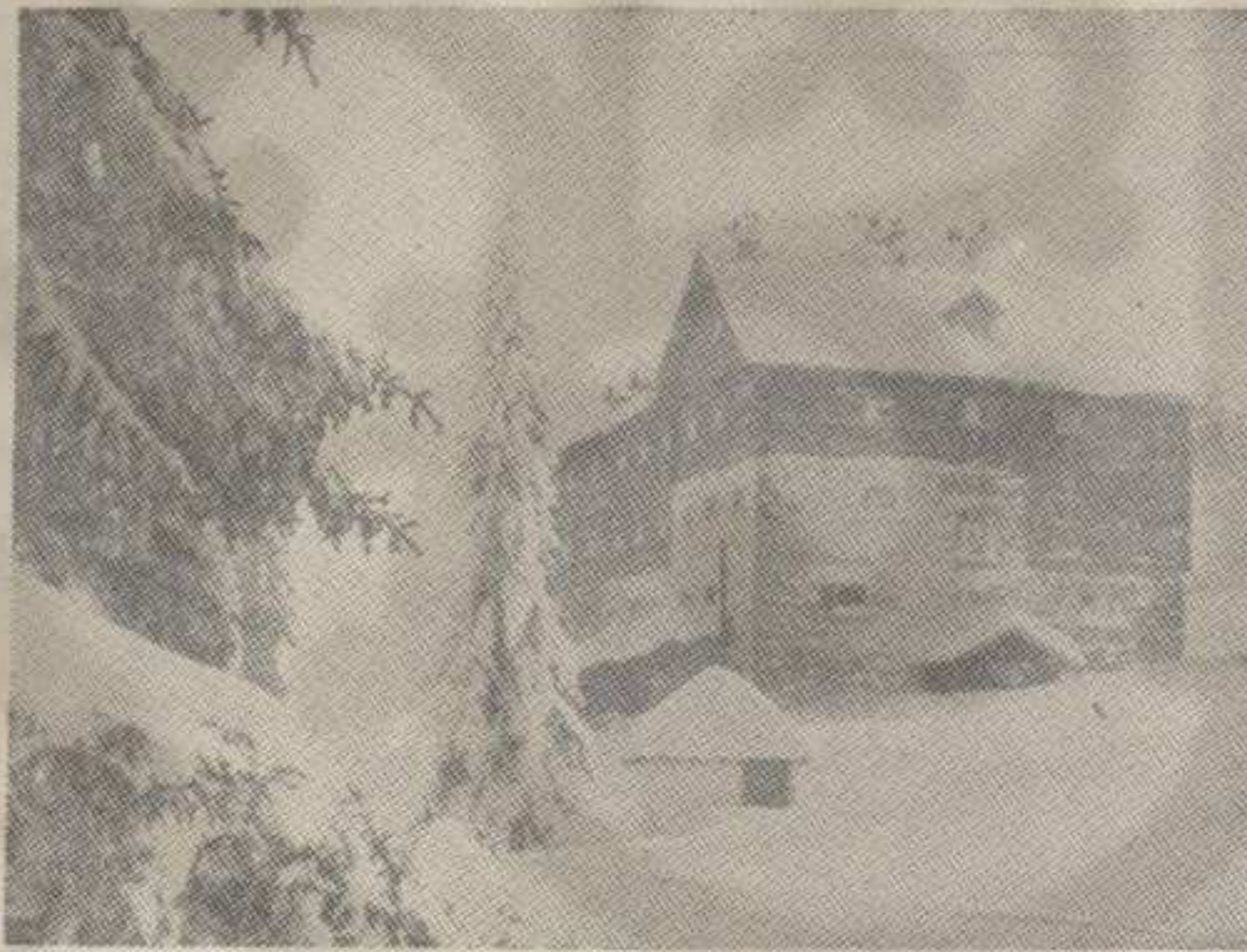
Некадашња лепотица Дом «Олга Дедијер» остао је запустен и склон рушењу
